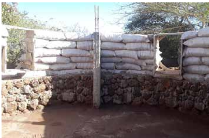
Une technique de construction très écologique
