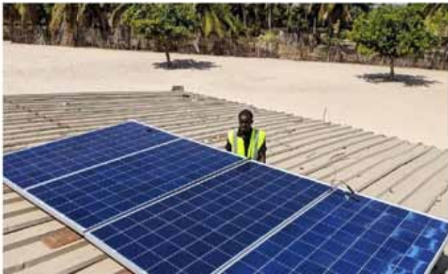
Les panneaux solaires sont installés par une entreprise de Dakar
