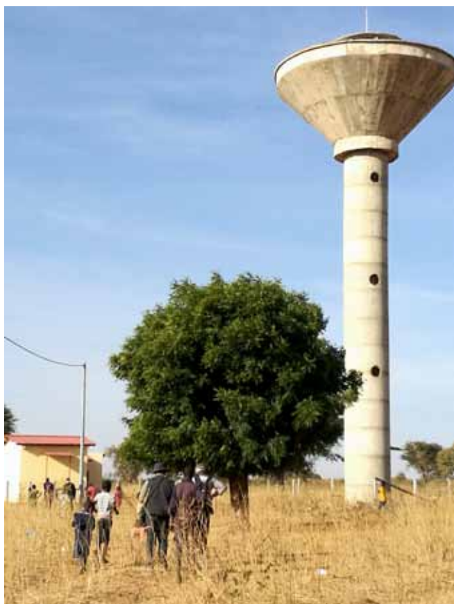
Il ne reste plus qu'à lancer la pompe... quand l'électricité arrivera
